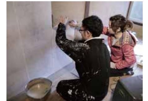
布海苔を溶かして糊状にし、土壁に和紙を貼って仕上げる
