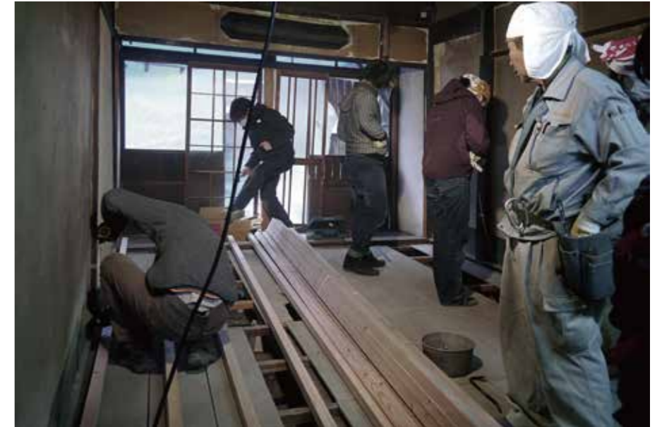
京町屋大工の棟梁・山本茂さんと3日間かけて床づくり。作業をしながら町家の構造の奥深さを学んだ。
