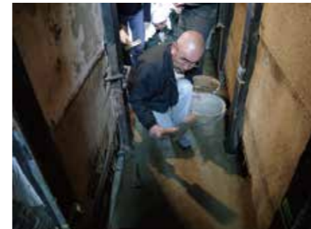
たたきにこだわりを持つ左官職人・萩野さんに教わる様子
